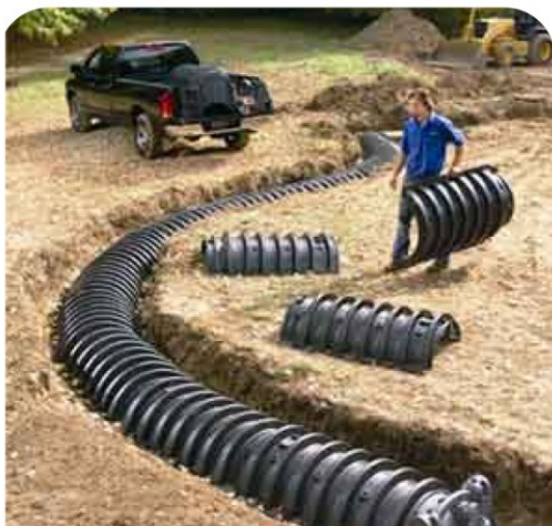
▪ MONTAJE DEL DRENAJE SÉPTICO MODULAR
